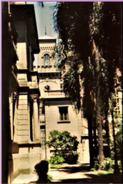
14. Otra toma de la misma torre.
