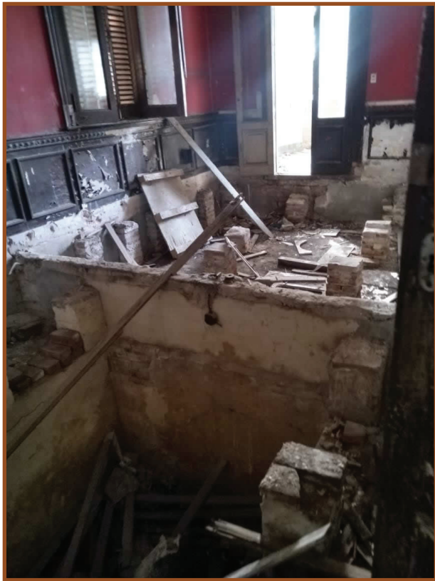
Pisos demolidos, soportes de piso robados.
