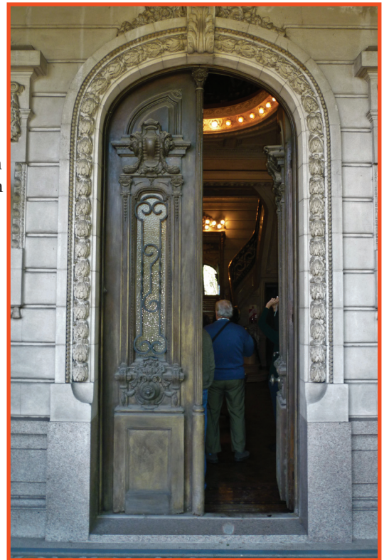
7.- Puerta de entrada. De roble, finamente tallada, ambas hojas con vidrio biselado. Tomada en 2009. Mantenía aun sus valores. Se adivina la iluminación interior en buen estado.
